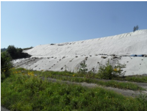
Reststoffdeponie St. Kosmas
