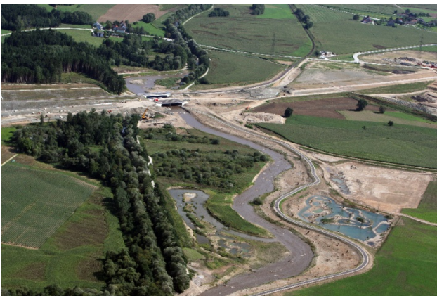
Der im Zuge der ÖBB-Maßnahme „Bahnhof Lavanttal“ neu angelegte Verlauf der Lavant bei Aich dient als Vorbild für weitere 400 m Laufverlegung im Life Projekt Lavant (Foto: ÖBB)
