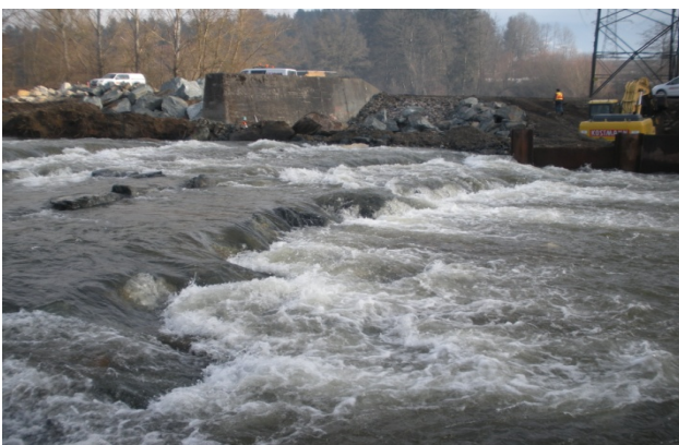
Insgesamt werden im Life Projekt Lavant u.a. vier Sohlstufen umgebaut, sodass sie wieder fischpassierbar sind.
