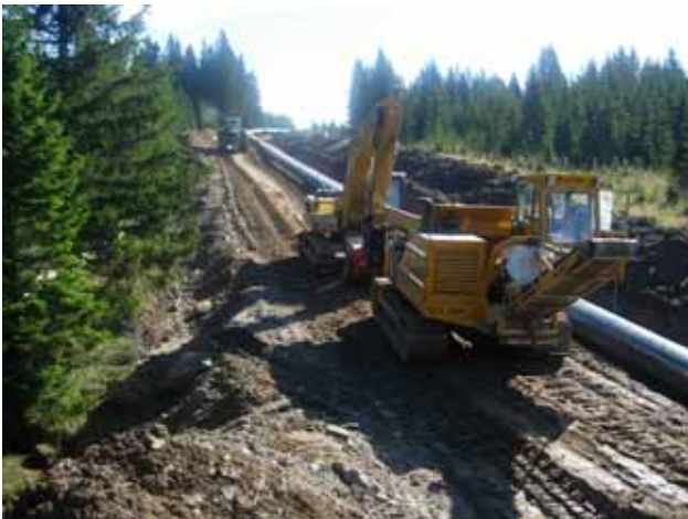
Bau einer Gasleitung (Trans-Austria-Gasleitung, LOOP II)
