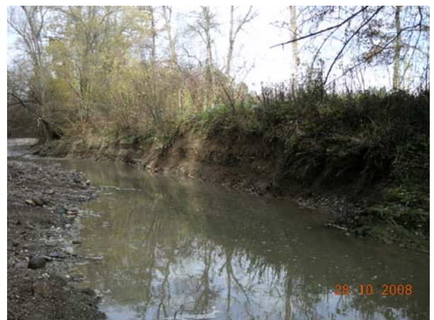
Ein Raubettgerinne macht die Wehranlage des Kraftwerk Gurk nun vor allem für Fische passierbar (oben). Flusstypspezifische Strukturen wie Steilwände für den Eisvogel werten den ökologischen Zustand der Restwasserstrecke der Gurk auf (unten).
